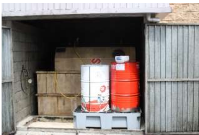
Almacenamiento de residuos peligrosos a cubierto y sobre cubeto. Consejería de Transición Ecológica, Industria y Desarrollo Económico. Gobierno del Principado de Asturias.
