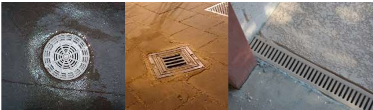
Ejemplo de arquetas/sumideros que no deben de encontrarse en la zona del taller. En caso de existencia se deberá justificar que no están conectados a red de vertido de ningún tipo. "Creative Commons" de dominio público (CC0 1.0 DEED).
