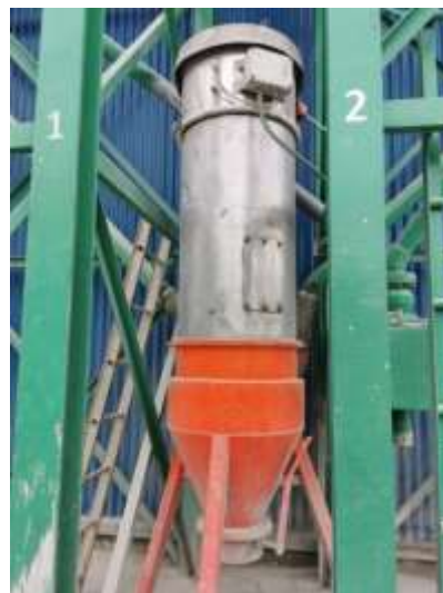
Ventee de silos de cemento con sistema de filtrado. Consejería de Transición Ecológica, Industria y Desarrollo Económico, Gobierno del Principado de Asturias (Hormigones Pelayo).
