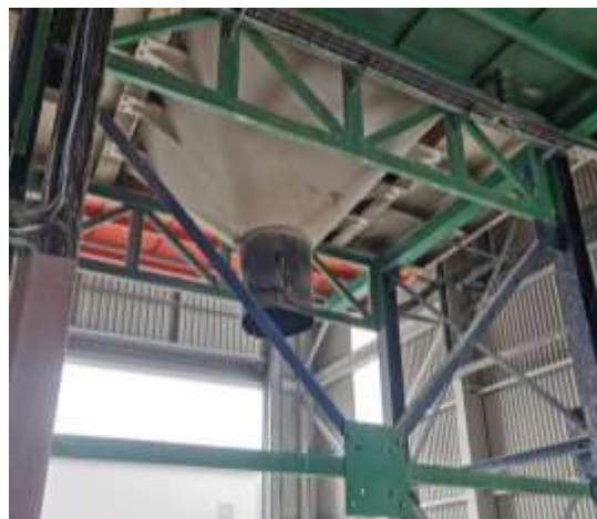
Boca de carga de hormigón a cuba. Consejería de Transición Ecológica, Industria y Desarrollo Económico, Gobierno del Principado de Asturias (Hormigones Pelayo).
