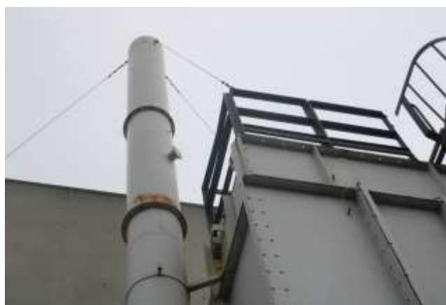
Orificio de toma de muestras. Consejería de Transición Ecológica, Industria y Desarrollo Económico, Gobierno del Principado de Asturias.
