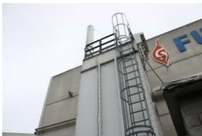
Acceso de gato para chimenea. Consejería de Transición Ecológica, Industria y Desarrollo Económico, Gobierno del Principado de Asturias.
